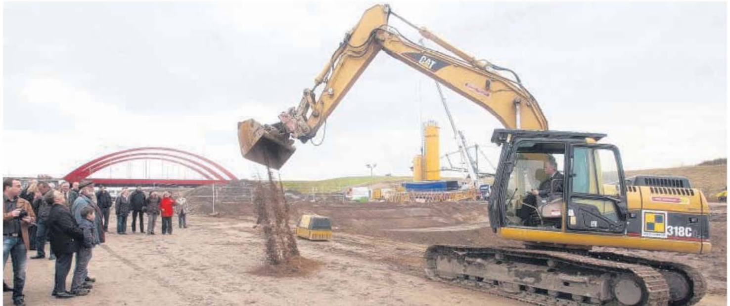
Symbolischer Akt: Bernd Klose macht mit dem ersten Baggerbiss den Weg für den Gewässerverbund zwischen Markkleeberger und Störmthaler See frei. Die Kanupark-Schleuse wird zudem der Abflussregulierung dienen. Foto: André Kempner
