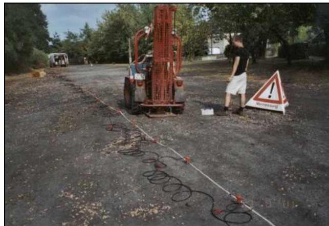
Seismische Messungen zur Lokalisierung von Hohlräumen
