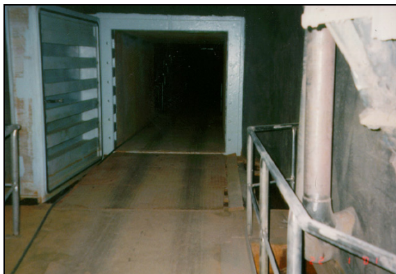
Flutungsdammtor für einen Staudruck von 2,3 MPa
