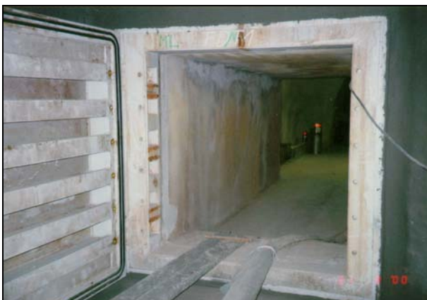
Detail der Türkonstruktion des Flutungsdammtores
