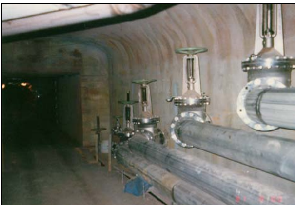
Durchführung von Rohrleitungen durch den Flutungsdammtorkörper
