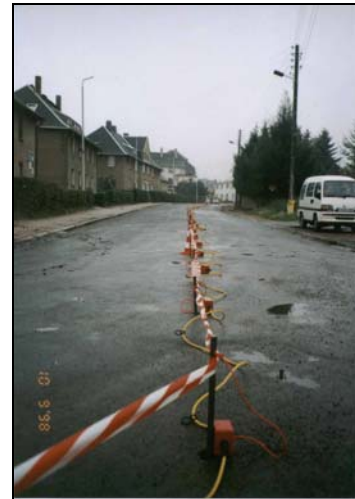
Multi-Elektroden-System RESECS im Einsatz
