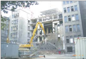
Abbruchmaßnahmen an der Rückfassade Reitbahnstraße
