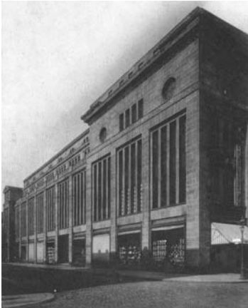
Warenhaus H&C Tietz Chemnitz 1912-1913
