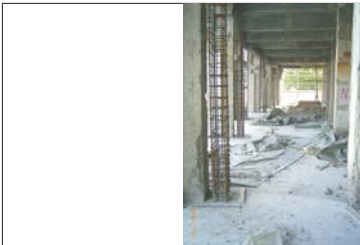
Betonsanierung Standsicherheitsmaßnahmen
