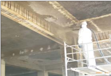
Betonsanierung Standsicherheitsmaßnahmen
