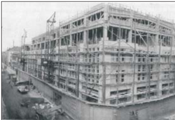
Fertiger Rohbau um 1913 mit Blick auf die Moritzstraße
