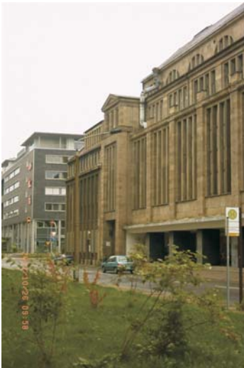
Das Basarke - Haus Gebäudeanbau von 1927
