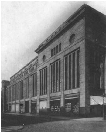
Warenhaus H&C Tietz Chemnitz 1912-1913
