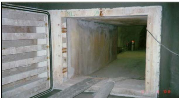
Detalle de una compuerta integrada en el cierre de hormigón
