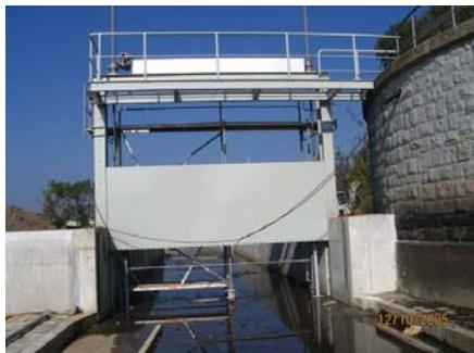
Bild 1: Einbau Spülschütz
