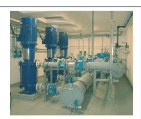
Rückbau der bestehenden Aggregate und Verrohrung zum Hochbehälter Elbingerode, Neubau Rohrleitungen und Pumpenaggregate einschl. Reinwasserpumpstation
