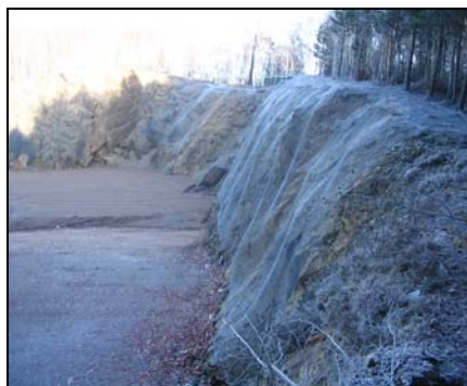
Bild: temp. Felswandsicherung
