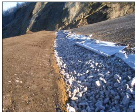
Bermen Ausbildung 3. Sohle
