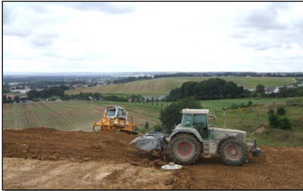
Ertüchtigung liegende mineral. Dichtungsschicht SA 2/3 (teilweise) KDB und Dränmatte SA 2/3 (teilweise)
