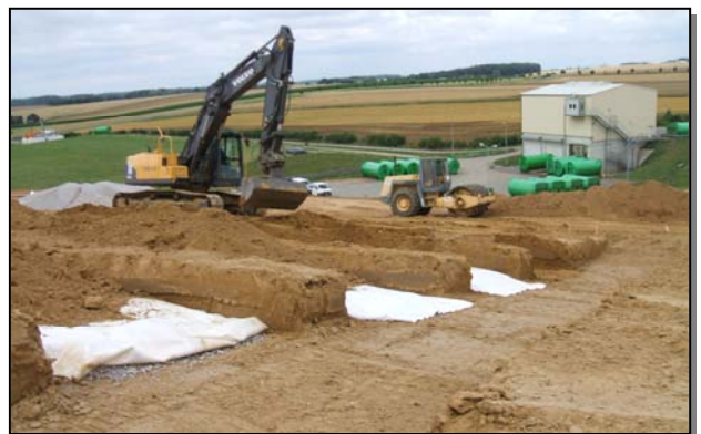
Rigolen für die passive Deponieentgasung
